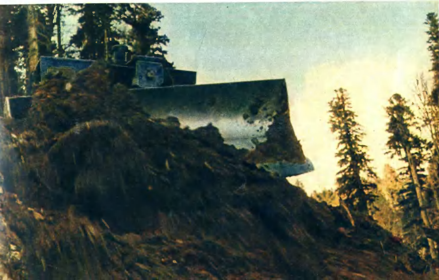
Вывозка древесины в горных условиях — дело нелегкое. Бульдозер пробивает новый участок дороги.
